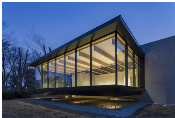
写真2 AFRW 1号物件(東京都日野市 帝人(株)敷地内)
