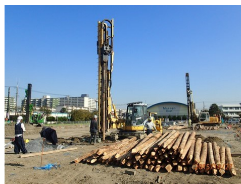
写真1 大規模分譲住宅における施工事例
