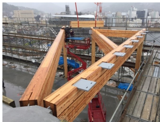
写真5 サッシ支持用プレート
