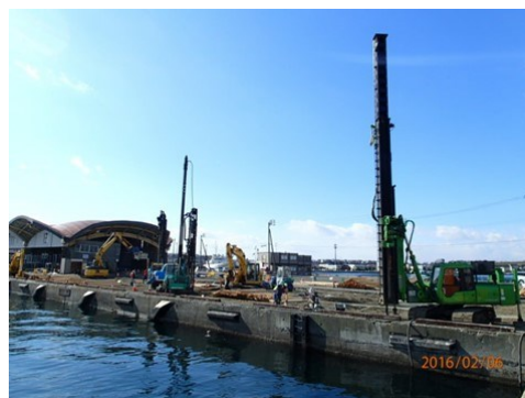
写真2 漁港岸壁の耐震強化における施工事例
