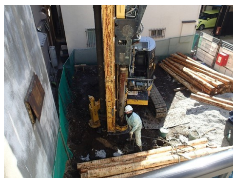
写真3 狭小地における4階建て戸建て住宅基礎の施工事例
