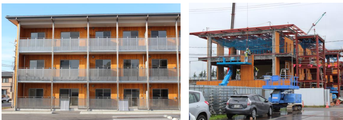
写真3 常磐関船団地（左：竣工写真 右：施工時の写真） 27世帯 設計：辺見美津男設計室 施工：藤田建設工業株式会社 W.ALC使用量 約200m 3
